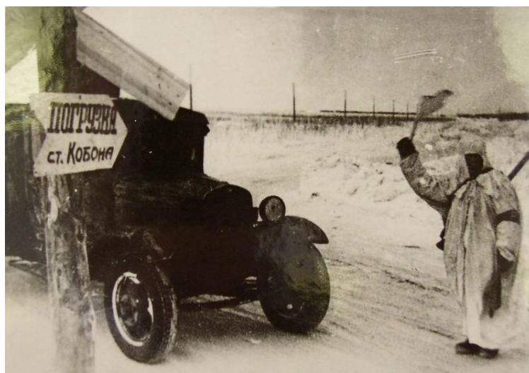
Станция Кобона. На заднем плане видна проложенная шестовая линия связи
